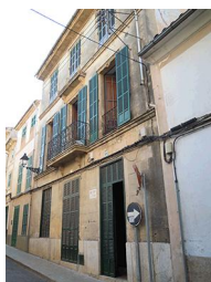
C/ de la Mar, 26 - Nivell: Catalogat (024-FE-ARC)
