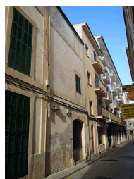
C/ Sol, 16 - Nivell: c
