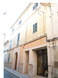
C/de la Mar, 22 - Nivell: b.2.3
