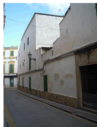
C/ Sol, 1(2) - Nivell: c
