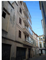
C/ Sol, 4 - Nivell: c
