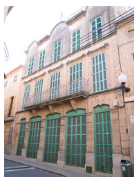
C/ de la Mar, 16 - Nivell: Catalogat (023-FE-ARC)
