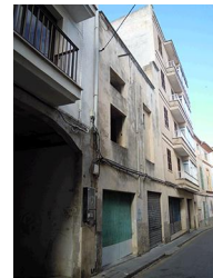
C/ Sol, 6-8 - Nivell: c
