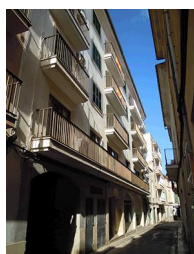
C/ Sol, 10-12 - Nivell: c
