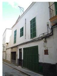
C/ Sol, 3 - Nivell: c
