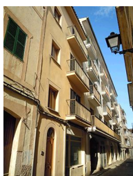
C/ Sol, 14 - Nivell: c
