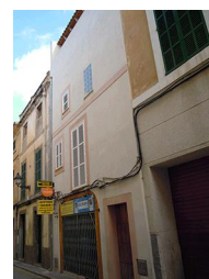
C/ Sol, 15 - Nivell: c
