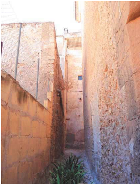
Fig 30. Vista interior del pas perimetral
