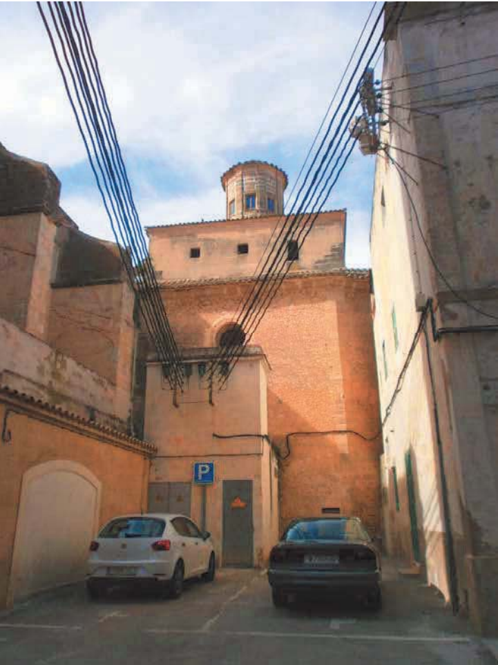
Fig 38. Vista estació transformadora
