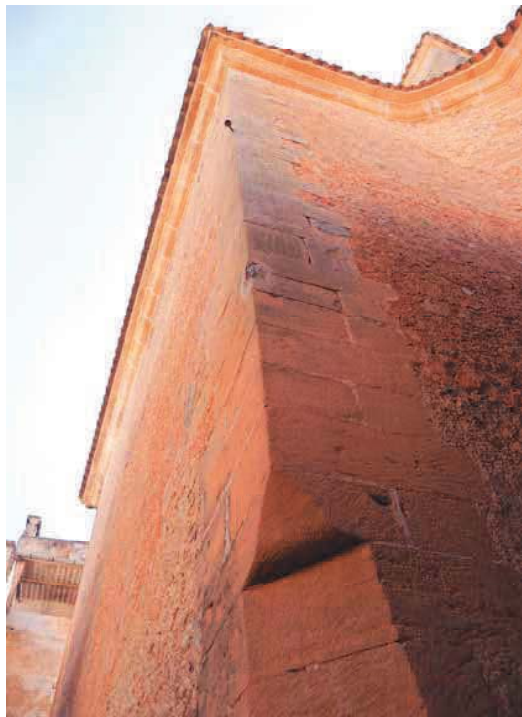
Fig 29. Vista interior del pas perimetral
