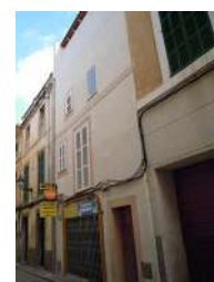
C/ Sol, 15. Nivell: c
