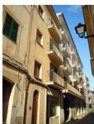
C/ Sol, 14. Nivell: c
