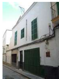
C/ Sol, 3. Nivell: c
