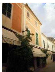
C/ Major 84 , 84 - Nivell: b.3
