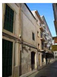
C/ Sol, 16. Nivell: c
