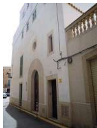
Pl de s'Arraval, 7 (1). Nivell: b.2
