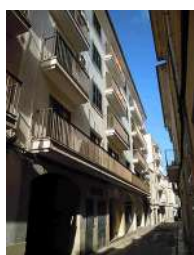
C/ Sol, 10-12. Nivell: c
