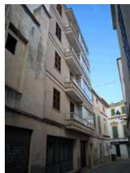
C/ Sol, 4. Nivell: c
