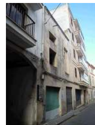
C/ Sol, 6-8. Nivell: c
