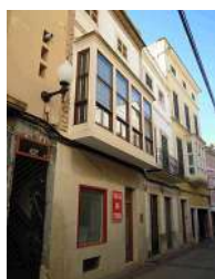
C/ Major 50 , 50 - Nivell: b.2
