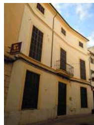
C/ Major 62 , 62 - Nivell: b.3
