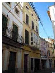
C/ Major 46 , 46 - Nivell: b.2
