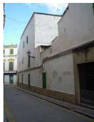
C/ Sol, 1(2). Nivell: c
