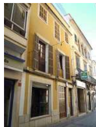
C/ Major 30 , 30 - Nivell: b.2,3
