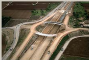
ROTONDA ELEVADA A LA M-3, c. 2000 Obra de construcció d'una rotonda elevada de l'autopista M-3, a prop de Campanet
