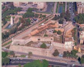
BALLUARI DE SANT PERE, c. 1997 Imatge del balluari de Sant Pere prèvia a l'inici de les obres de la construcció del Museu d'Art Modern i Contemporani de Palma, El Balluard
