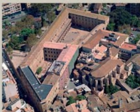
GRUPO DE REHABILITACIÓ DE LA MISERICORDIA, c. 2006 Vista aèria de les obres de reforma de la Misericòrdia, des de la fase de rehabilitació integral de l'edifici
